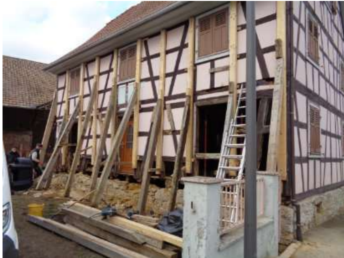
Remplacement de sablière à Helfrantzkirch ©CAUE d'Alsace
