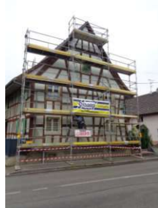
Travaux de restauration d'un pignon - Kappelen ©CAUE d'Alsace
