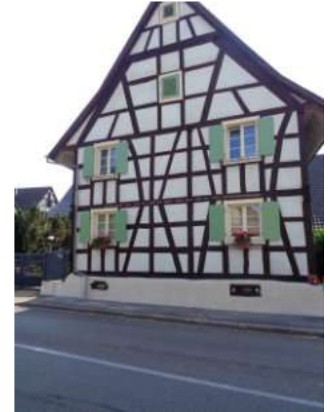
Pignon après restauration - Kappelen ©CAUE d'Alsace
