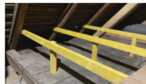
Isolation du plancher d'un grenier, ouate.
