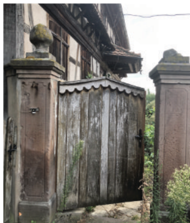
Hindisheim, portillon avant rénovation
