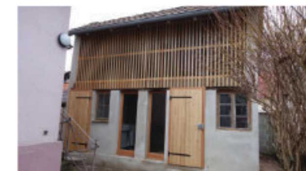
Illkirch-Graffenstaden, appentis rénové
