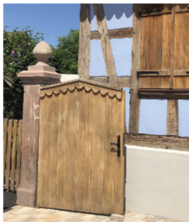
Hindisheim, portillon après rénovation
