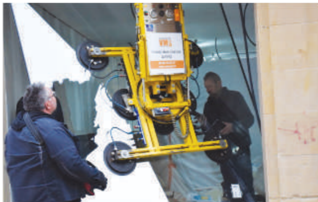
Changement des vitrines par du double vitrage ©CAUE-Alsace
