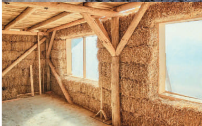
Isolation intérieure paille ©CAUE-Alsace
