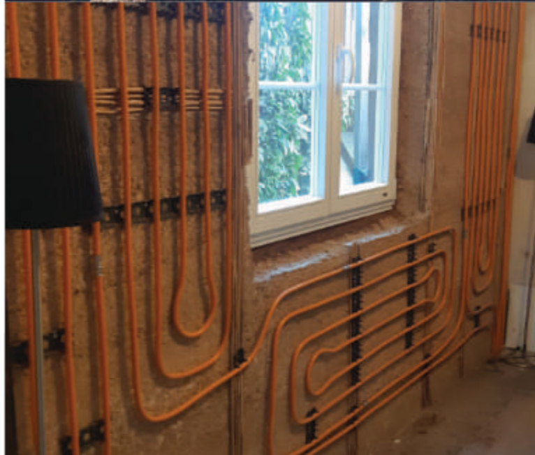
Murs chauffants sur chaux chanvre - Erstein ©CAUE-Alsace
