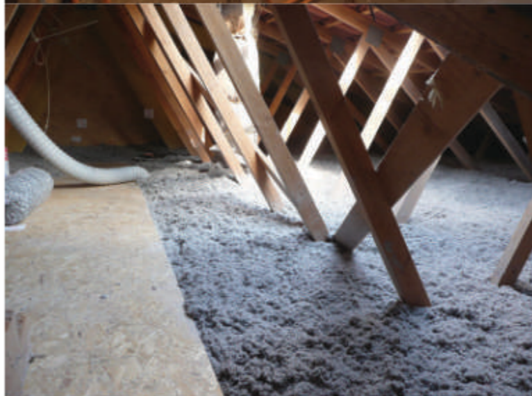
Isolation comble perdu ©CAUE-Alsace
