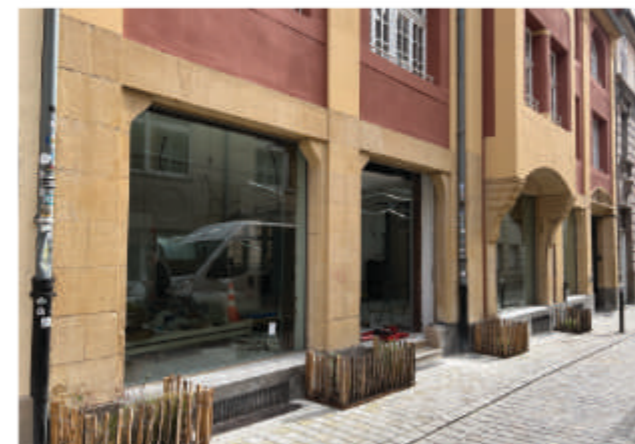
Les vitrines du futur espace de diffusion culturelle du CAUE d'Alsace ©CAUE-Alsace
