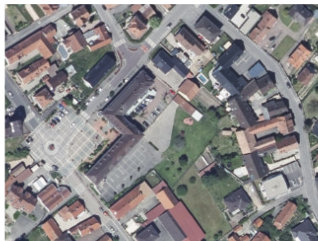
Vue aérienne de l'école de Oberhoffen-sur-Moder ©Google Maps
