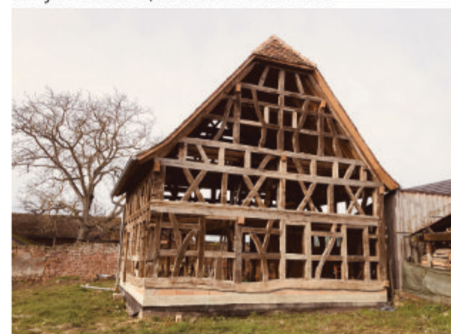
Maison Walff ©CAUE-Alsace
