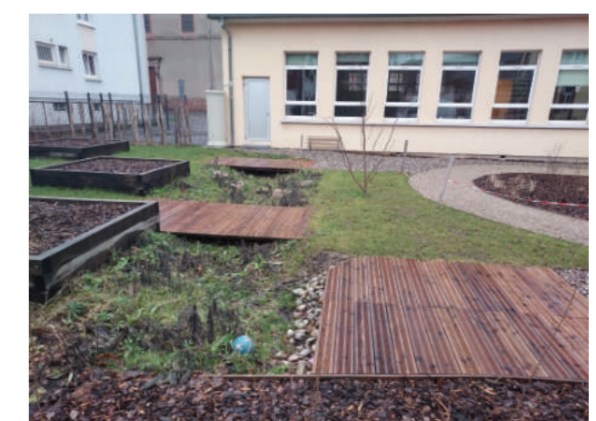
Noue d'infiltration - Cour Bitschwiller-Lès-Thann ©CAUE d'Alsace
