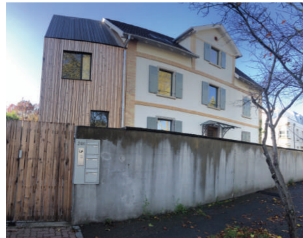
Extension bois maison ouvrière
