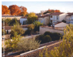
Favoriser les continuités par les cours et jardins et constituer des tris de fraîcheur végétalisés et perméables.
